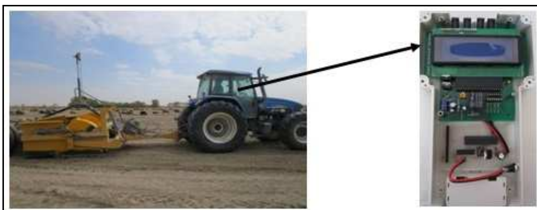
شکل ۴- سامانه ساخته شده در حالت کاری
